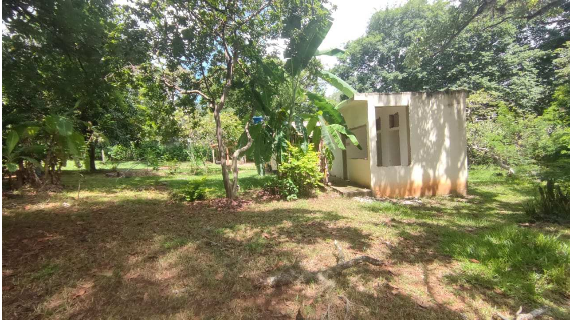
Fotografia 7 – parte da edificação existente
