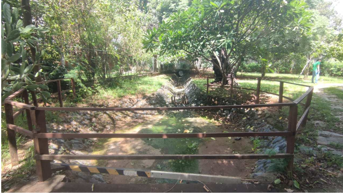
Fotografia 5 – visão do canal existente
