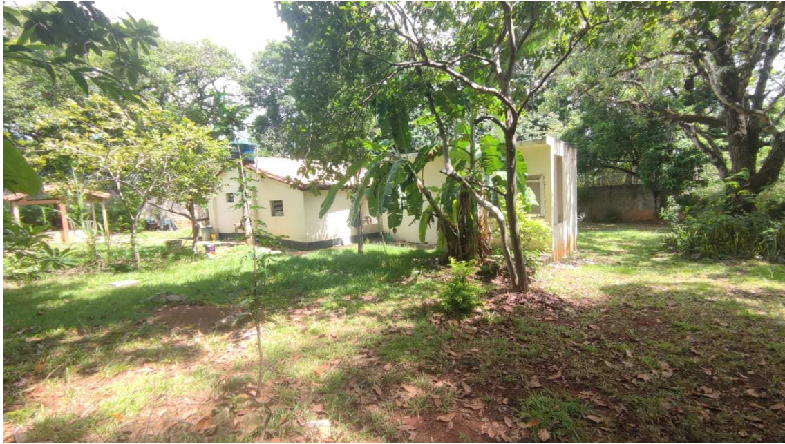
Fotografia 9 – parte da edificação existente
