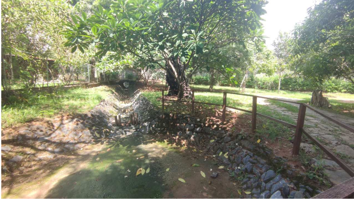
Fotografia 3 – visão do canal existente
