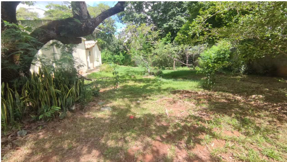
Fotografia 8 – parte da edificação existente
